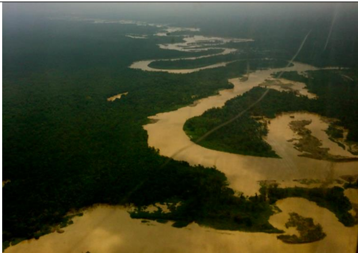
Folio 2131 del Cuaderno de pruebas Núm. 5. Destrucción del cauce del río Atrato. Enero 29 de 2016.
